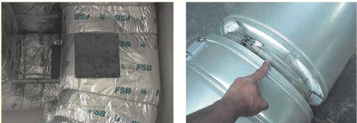
그림1. 현장 시공된 인클로저와 공장 제작된 인클로저 설치 예 (사진출처, NFPA)
