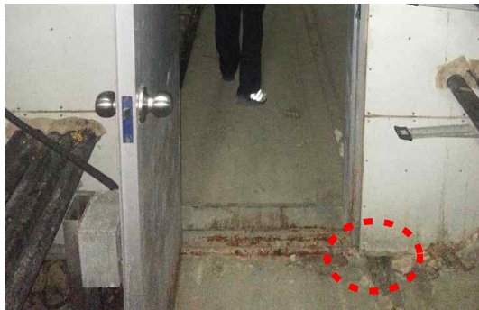
그림 42 트렌치로 인한 방화벽 불량 사례
