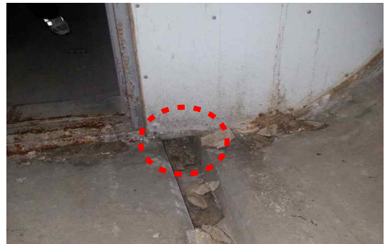
그림 42 트렌치로 인한 방화벽 불량 사례
